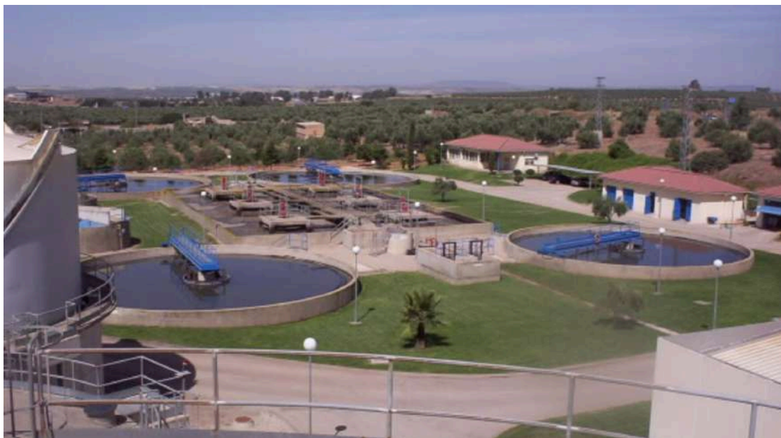
Depuradora de aguas residuales de Linares. / Linaqua
