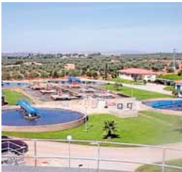
Imagen de archivo de la EDAR antes de su ampliación. LINAQUA
