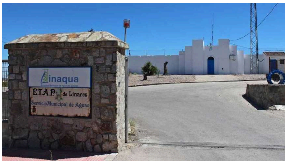
Entrada de la ETAP de Linares / Cadena ser
