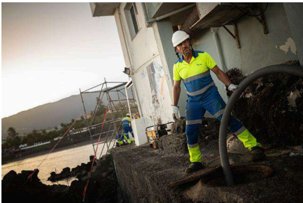
Obras de emergencia en el colector de Punta Brava, en Puerto de la Cruz / Arturo Jiménez
